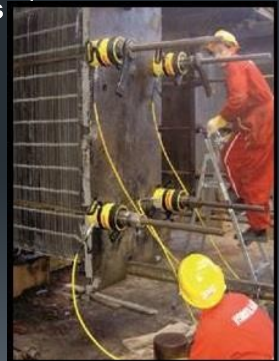
Montage sur site
